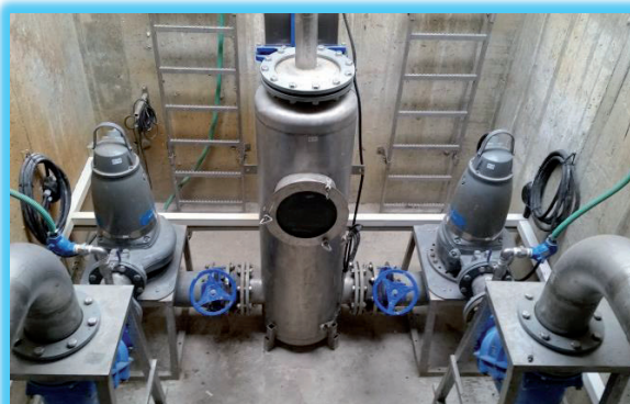
Rys. 3.4.3. Sucha przepompownia ścieków [8]
