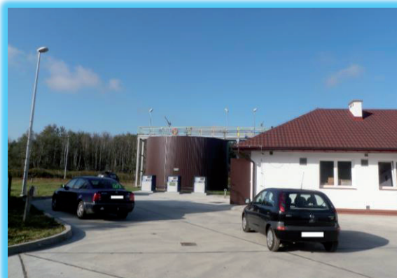
Rys. 3.3.6. Gminna Oczyszczalnia Ścieków w m. Młyny [26]
