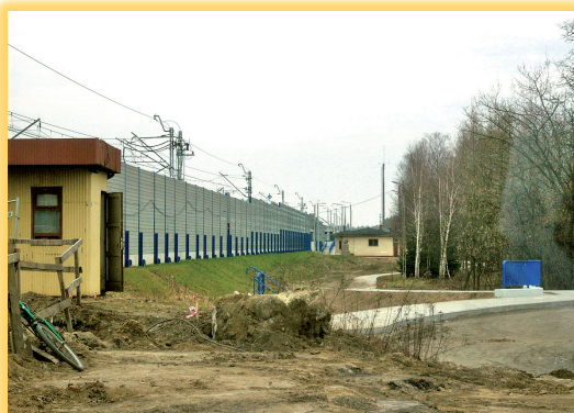
Rys. 4.3.2. Ekrany akustyczne, linia kolejowa E30 [26]
