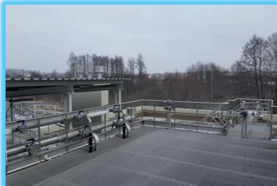
Rys. 3.4.1. Reaktor MBR, w głębi reaktor SBR [8]
