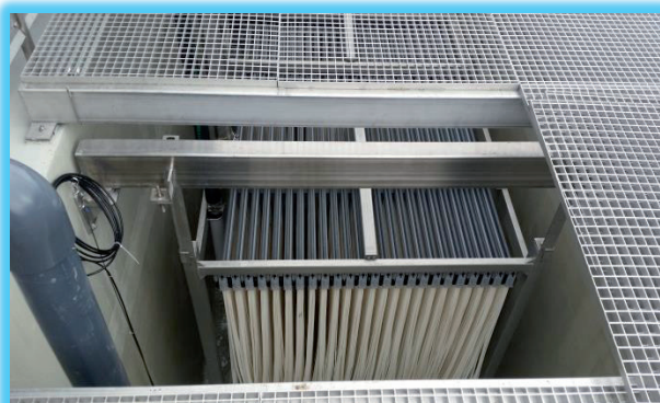
Rys. 3.4.2. Kaseta z membranami [8]
