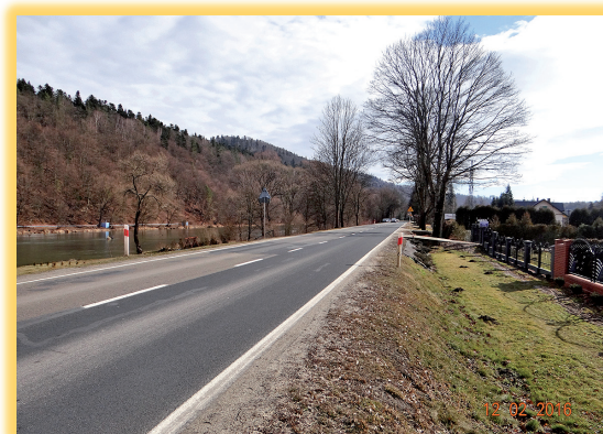
Rys. 4.2.6. Stanowisko pomiarowe monitoringu hałasu w m. Łączki, Wielka pętla bieszczadzka w 2016 r. [26]
